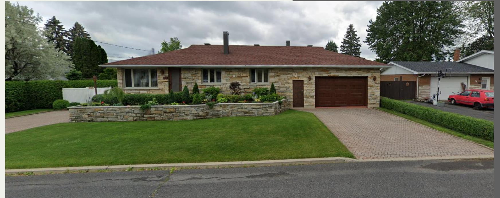
706, rue Maple Voisin arrière
