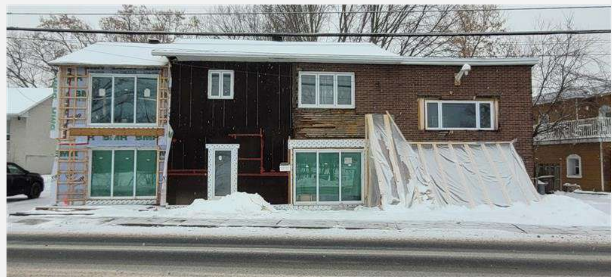
203 à 207, chemin du Richelieu (voisin de droite)
