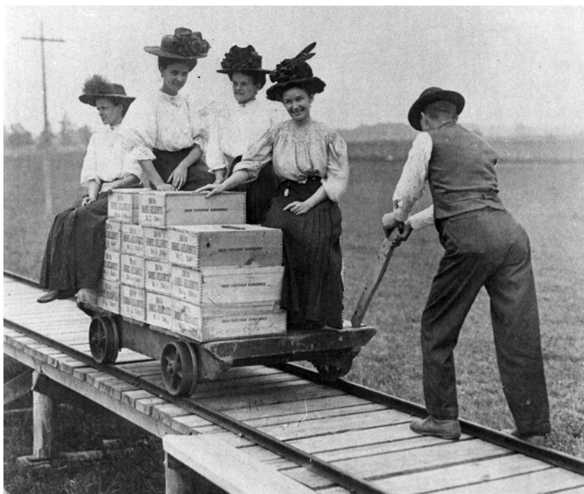
Figure 25. Ouvrières endimanchées sur des caisses de dynamite, vers 1915 (SHBMSH, P04, cart. 7, p. 34).
