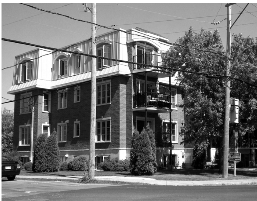
Figures 29 et 30. L'École Sacré-Cœur construite sur la rue Richelieu, au coin de la rue de l'École en 1925. Les Sœurs de la Présentation de Marie y ont enseigné pendant une trentaine d'années. L'édifice fut démoli en 2004 pour cause de vétusté. (SHBMSH, Collection Jean-Claude Adam) — L'édifice de condominiums construit récemment sur le même site. (Collection Gilles Plante).
