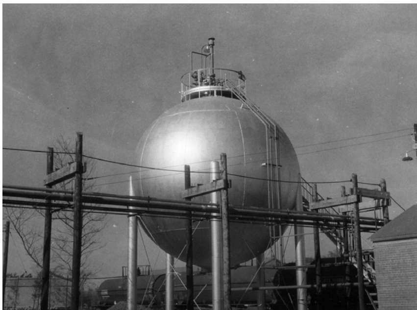
Figure 8. Réservoir sphérique d'ammoniaque, vers 1960 (Collection Gilles Plante, 121-030).
