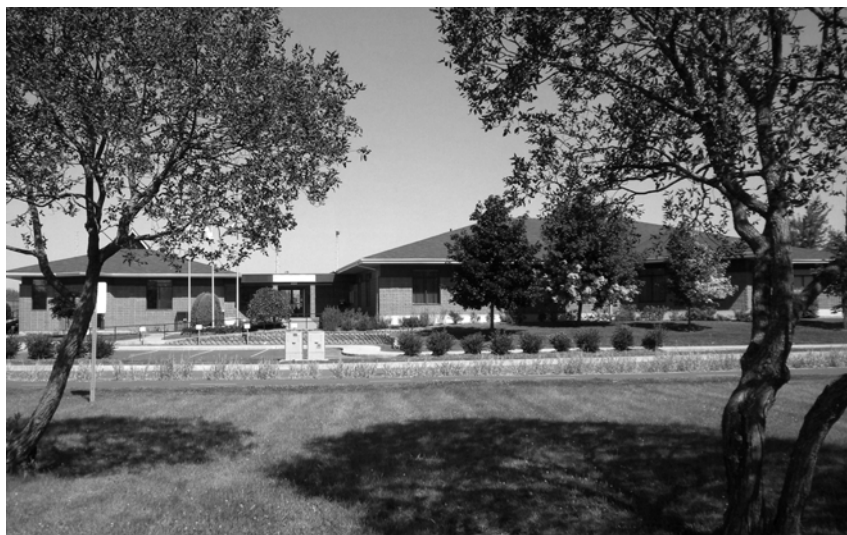
Figures 13 et 14. En haut, l'ancien hôtel de ville de McMasterville sur la rue Caron, inauguré en 1963. Ce bâtiment sert maintenant de caserne aux pompiers et abrite également les activités de la FAD00. (Archives de McMasterville). En bas, le Centre communautaire intégré situé sur le boulevard Constable qui comprend les activités de la mairie et une caserne de pompiers. (Collection J-Roger Cloutier).
