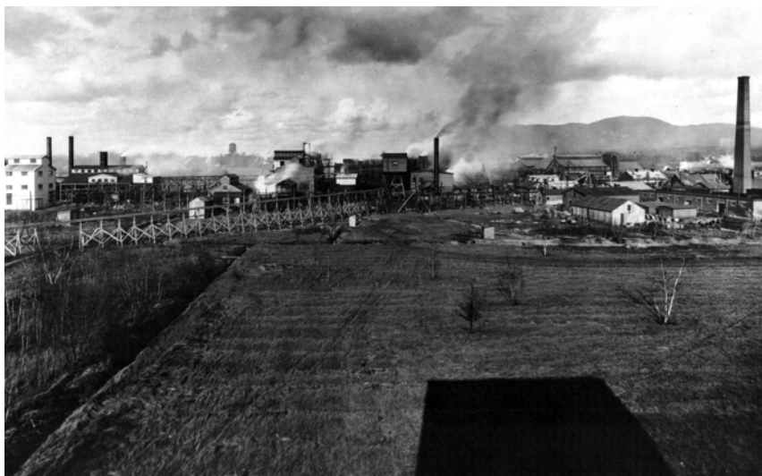
Figure 6. Vue générale de la Canadian Explosives Company (CXL) vers 1915 (SHBMSH, P04, cart. 7, p.24)
