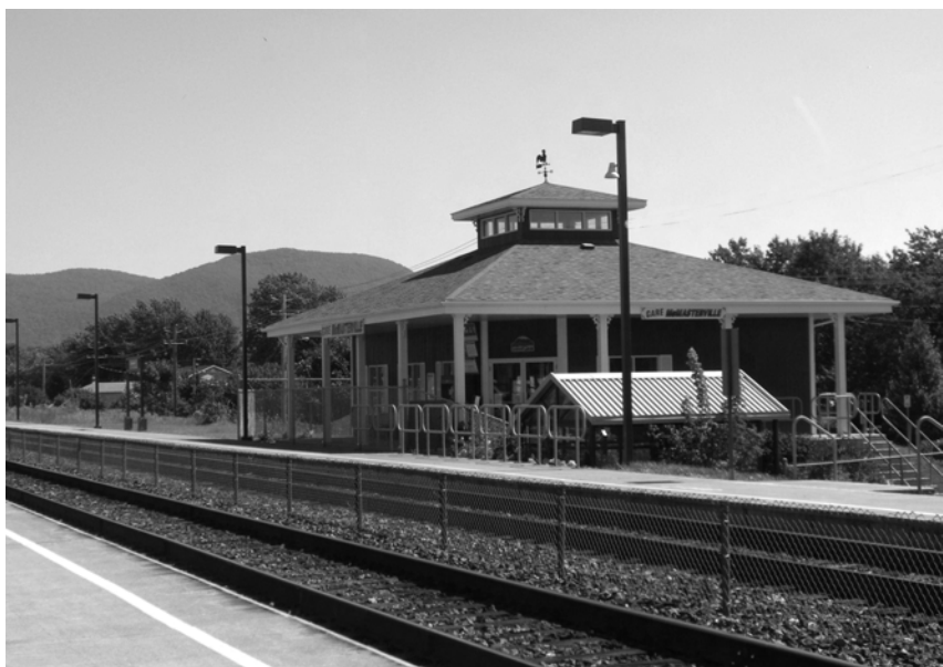
Figures 35 et 36. La gare : en haut, le chemin de fer avant l'érection de la gare; en bas, la gare ferroviaire de McMasterville en 2010 (SHBMSH., P04, cart. 7, p. 1 — Collection, Gilles Plante).
